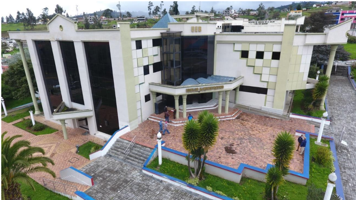
Figura 1: Fachada del Edificio Administrativo Fuente: Unidad de Comunicación Institucional
