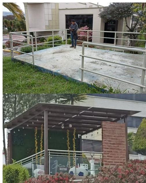
Figura 12: Antes y después de la pérgola
